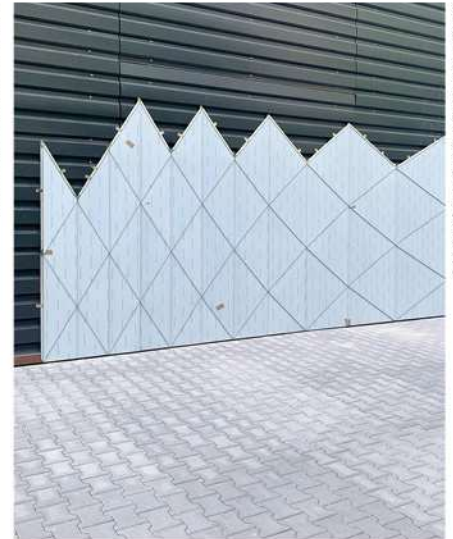
Die Befestigung der Trapezprofiltafeln erfolgte an dahinter angeordneten Strangpressprofilen
