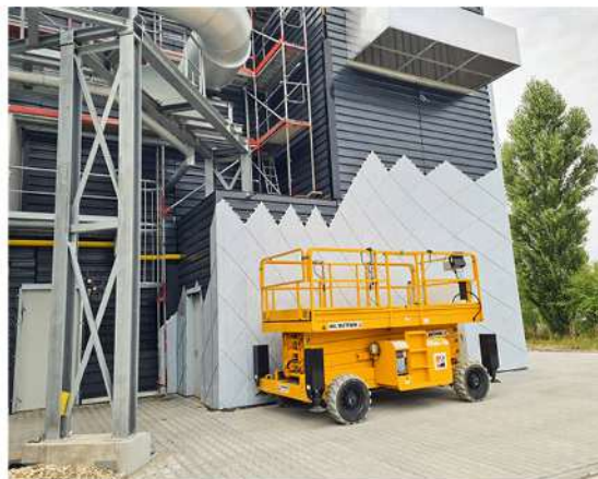
Zur Montage der Schindeln wurden Rollgerüste und Scherenlifte verwendet
