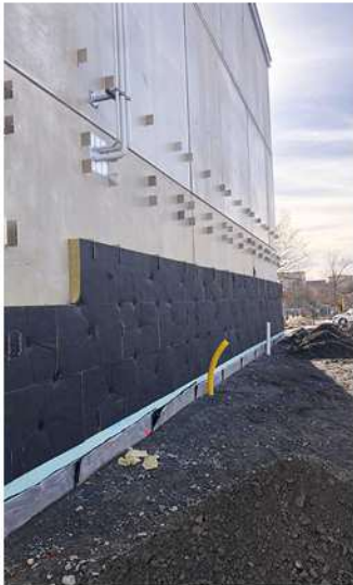
Montagestart: Installation von Konsolen und Wärmedämmung
