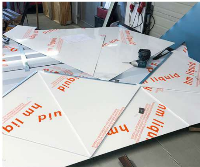
Entwicklung der Schindelzuschnitte samt Zuschnittoptimierung
